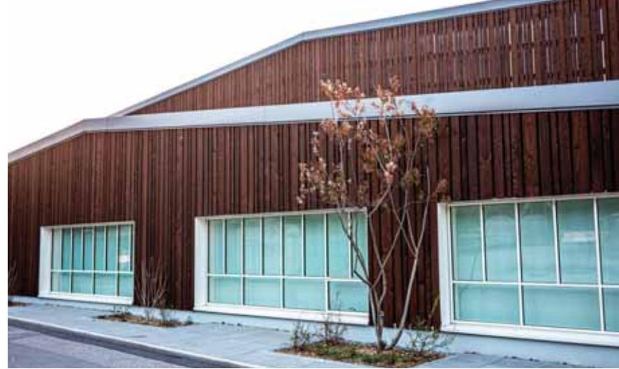
Sur les fondations des anciens hangars en bois, la nouvelle halle s'est implantée. Construite en structure métallique, elle est recouverte d'un bardage bois qui rappelle les anciennes constructions. Les nouvelles fenêtres, aux serrureries fines, s'harmonisent à l'architecture industrielle de l'époque présente sur le bâtiment voisin. Cette grande halle accueille les nouveaux bureaux du chantier naval, un atelier mécanique ainsi qu'une grande salle
