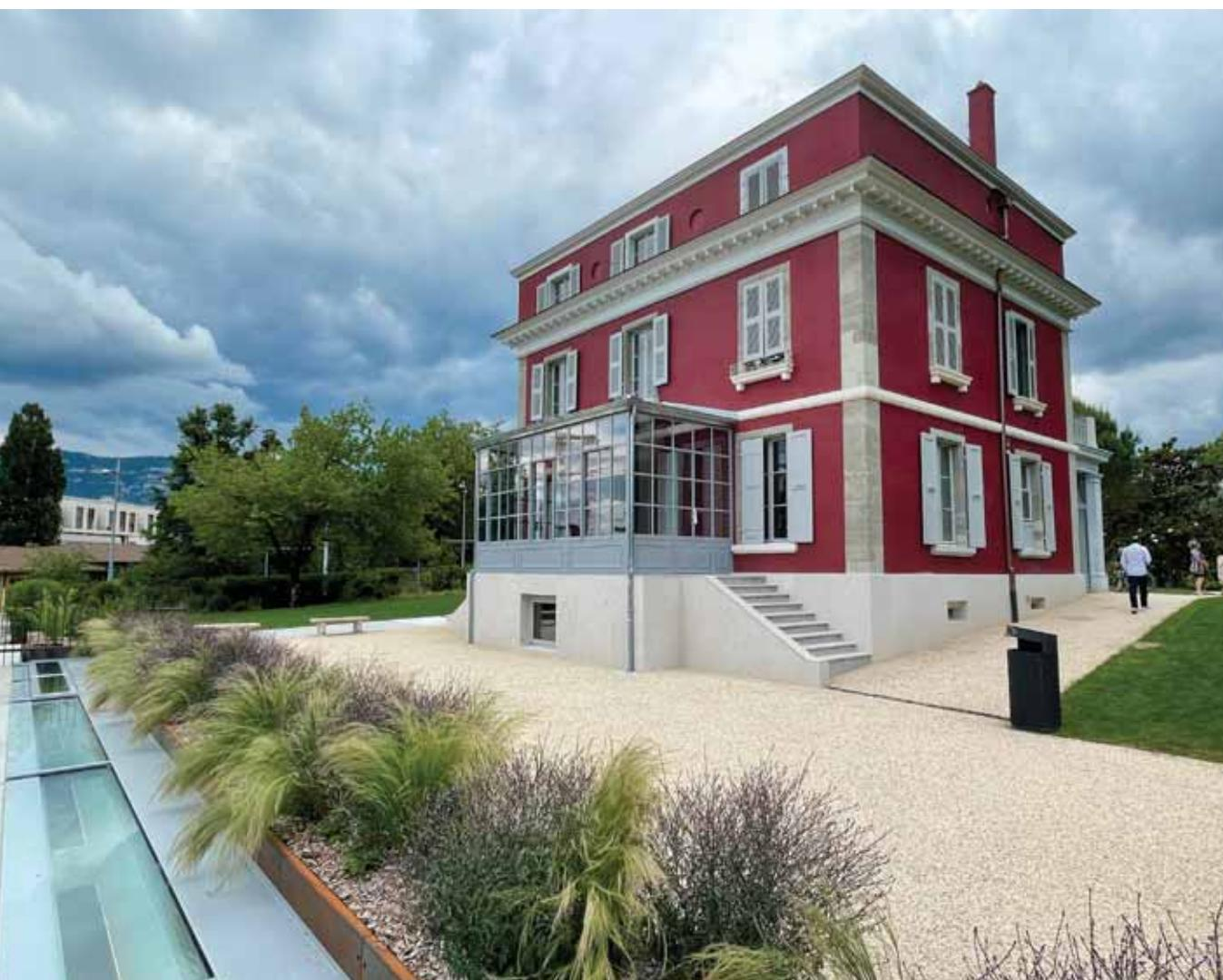
Le jour zénithal filant le long du mur de soutènement et se retournant sur la porte tiercée est intégré au niveau du parvis dans les bacs de plantes faisant office de barrières anti-chute. Le promeneur, sur le parvis, ne voit que la verdure du premier plan se fondant dans celle du vallon de l'Aire qui coule en contrebas.
